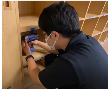
図3：取り付け作業の様子
