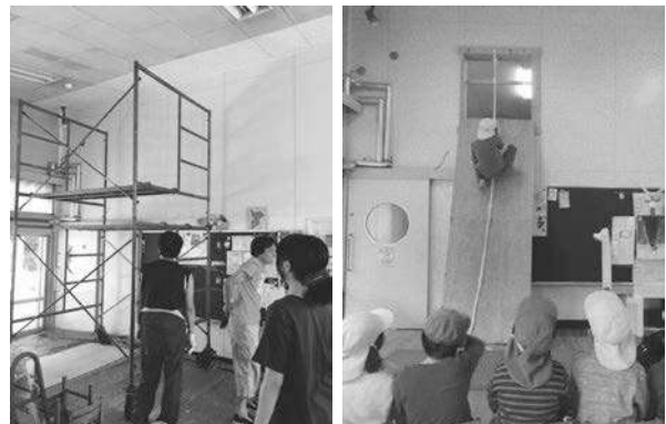
図2 年中児棟に設置した登坂遊具。 足場を組んで2階倉庫部分の壁をくり抜いた。1階部分は洗面所になっているが、壁の開口部はそれより上にある。
