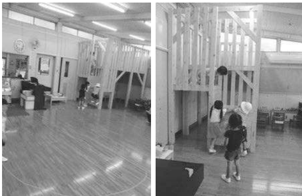
図1 年少児棟に設置したロフト風の遊具。 設計は工学部デザイン学科 原研究室が行い、原研究室指導の下、保護者と幼稚園教員が材料を加工し、組み立てた。
